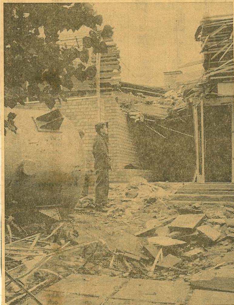
Besökspaviljongens framsida splittrades delvis av gasbehållaren, som ses t. h. på bilden.
